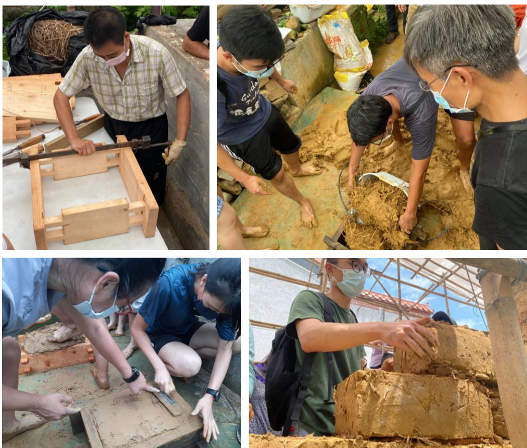
圖 229. 「古建技藝·文化傳承 — 荔枝窩」泥磚工作坊 445
